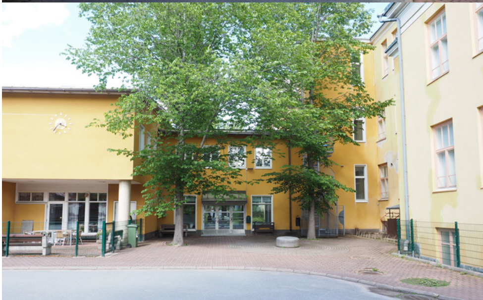
Etelänpuoleista pihaa ja uuden osan sisäänkäyntejä. Yhdyskäytävän ikkunat ovat pystysuuntaiset, poiketen muista uuden osan ikkunoista.
