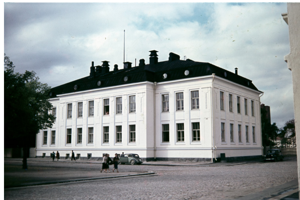
Kuva vuodelta 1955. Pohjoispäädyn piiput on purettu ja kellarin aukkoja suurennettu. Valokuvaaja Sven Raita. Kuva Satakunnan museo
