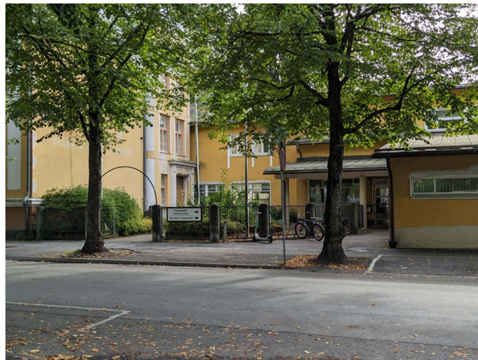
Vanhan ja uuden osan sisäänkäynnit ja pohjoispuolen piha-aukio. Jykeväpilarinen aita ja kaariportti on tehty laajennuksen yhteydessä.
