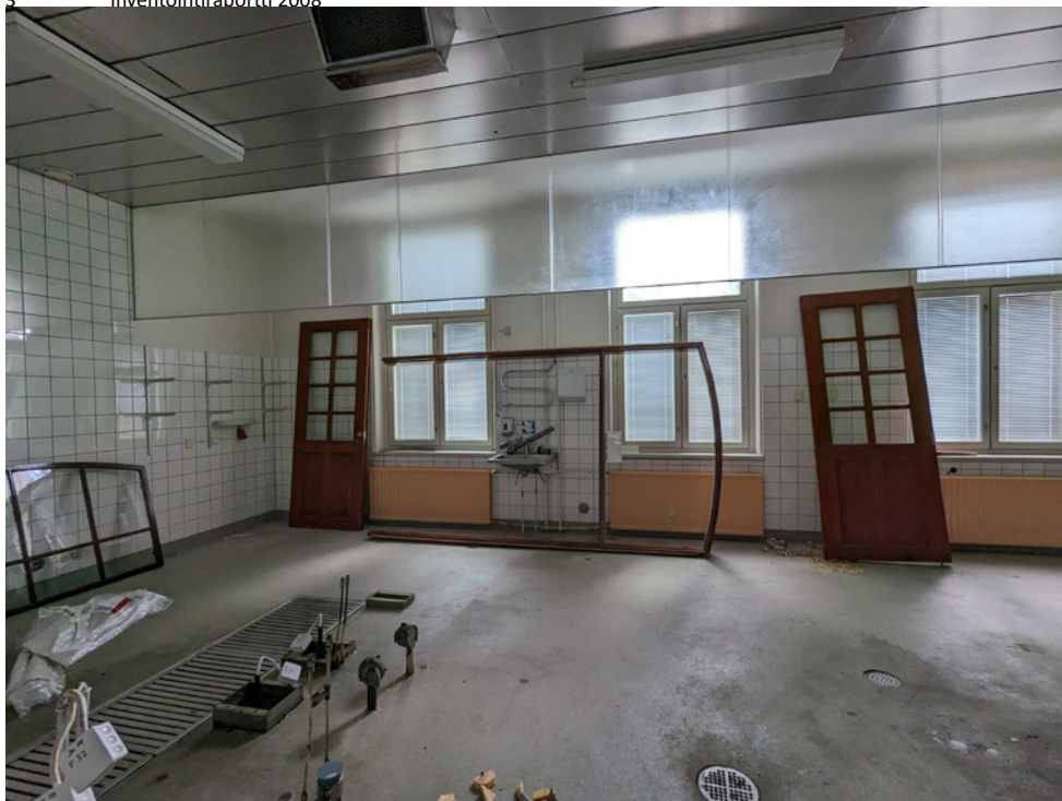
1980-luvun alussa rakennettujen ravintolakeittiöiden laitteet on purettu. Ovet ovat uusien palo-ovien tieltä purettu porrashuoneen ovet.
