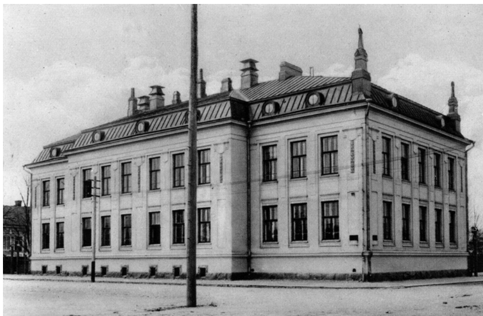
Ajoittamaton kuva oletettavasti ennen 1944 suurkorjausta. Kuva Satakunnan museo
