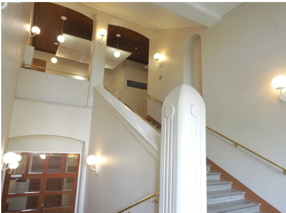
Näkymä 2. kerroksen ja ullakon väliseltä tasanteelta. Porrashuone on edelleen juhlava ja valoisa. Sivuseinällä näkyy yhdyskäytävän rakentamisen yhteydessä ummistetun ikkunan sijainti. Lattian pintamateriaali on säilynyt.
